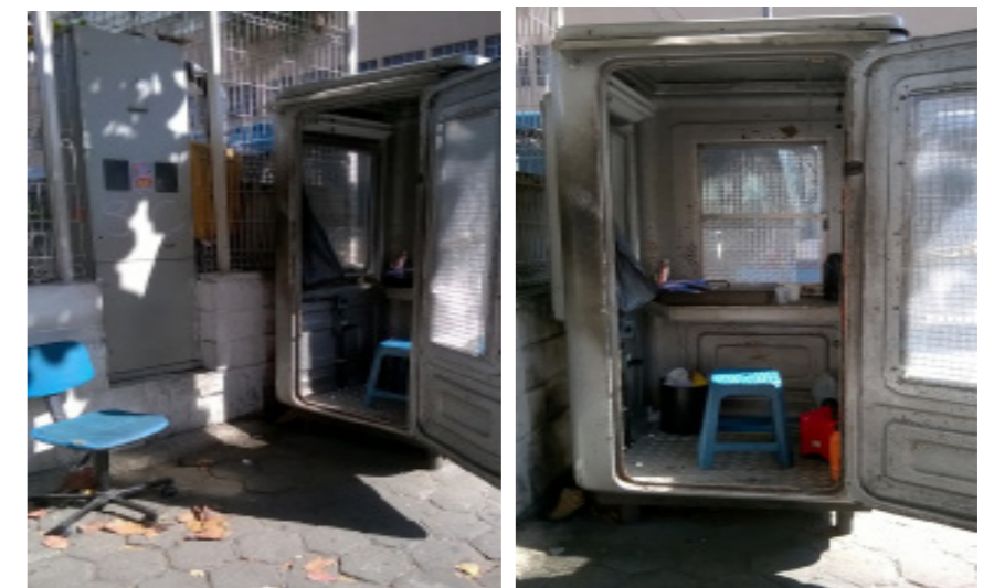
Cabine em condições precárias, cadeiras quebradas e goteiras em dia de chuva.
