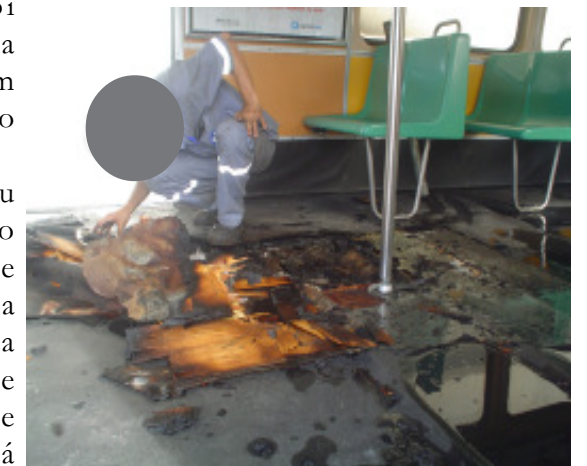
Carro destruído pelo fogo em 2010
